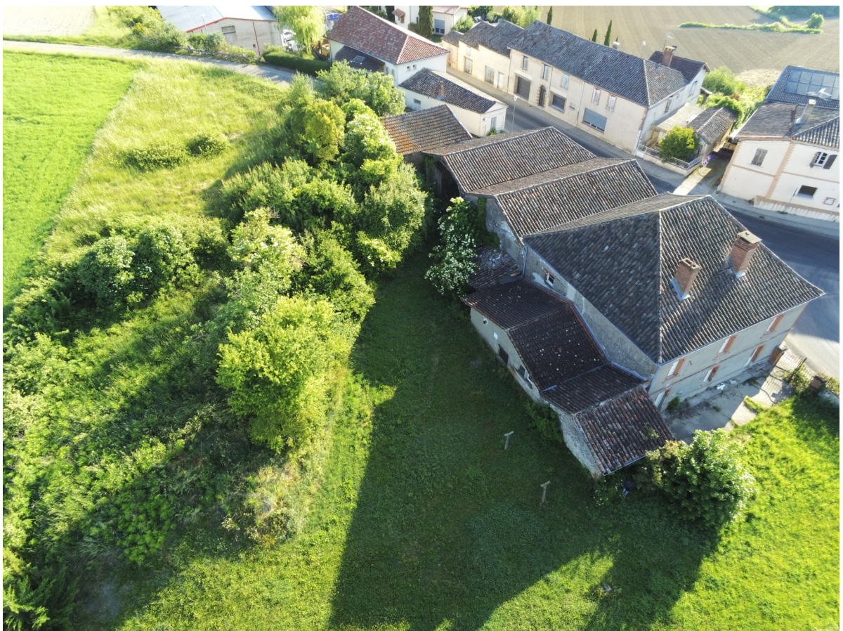
Vue aérienne de l'arrière de l'immeuble, du futur parking et des jardins, avant travaux.
